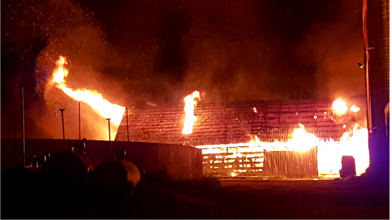
Un bâtiment consumé par les flammes. Photo – Martin Falardeau
