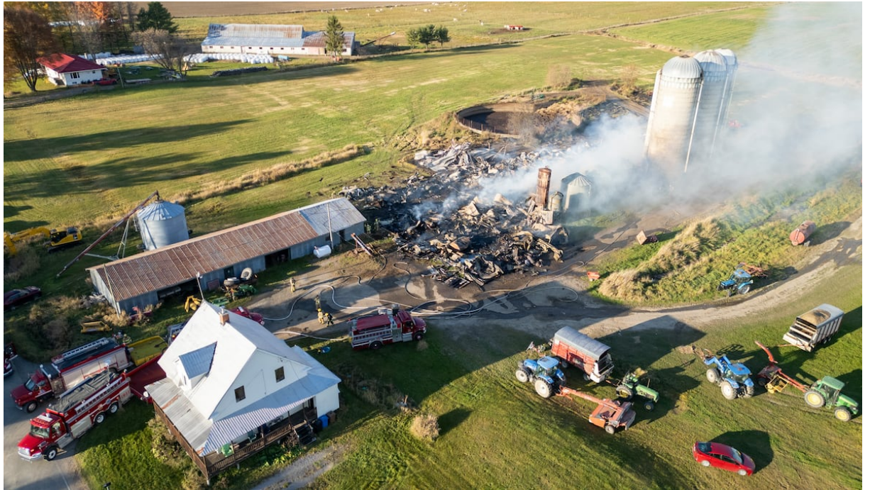
À l'arrivée des secours, une partie du bâtiment en flammes s'était déjà effondré. (Stéphane Lessard/Le Nouvelliste)
